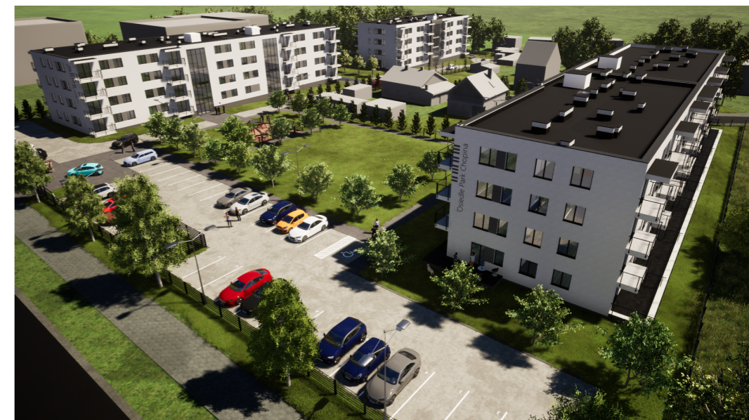
LOKALIZACJA W BUDYNKU
